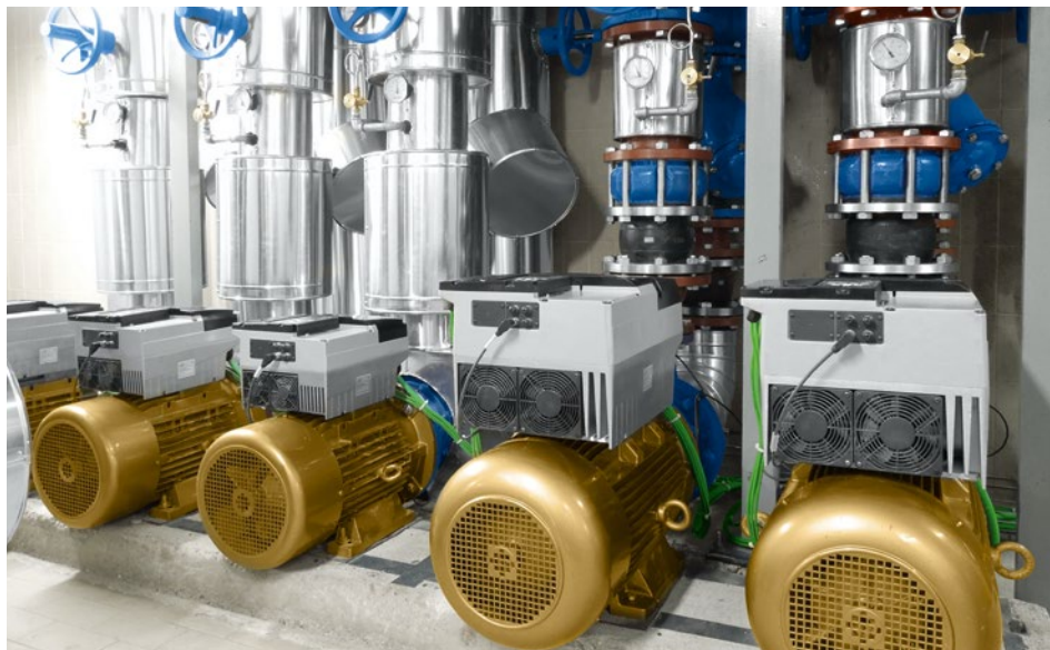
Efficienza energetica garantita con pompe dotate di motore KSB SuPremE® IE5*, PumpDrive e PumpMeter.
