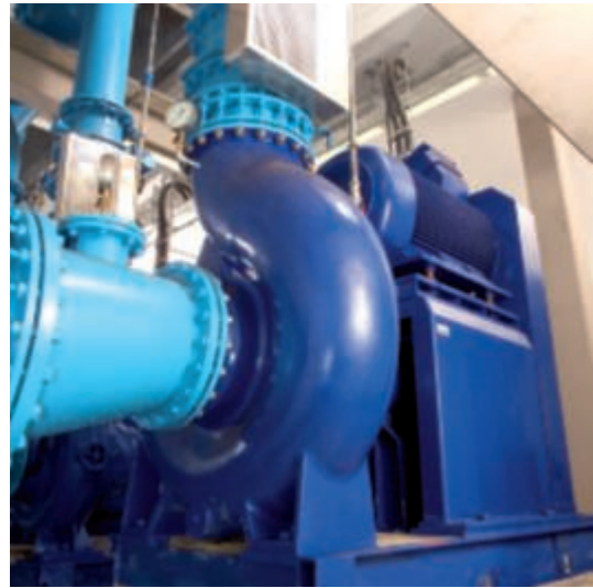
Die Spiralgehäusepumpe Sewatec fördert Schmutzwasser jeder Art.
