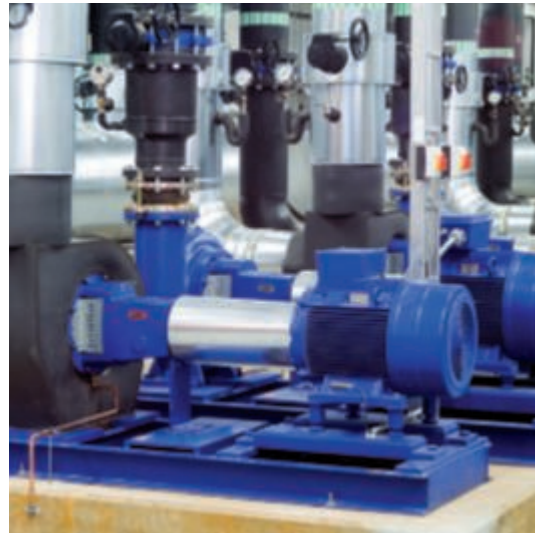
Spiralgehäusepumpe Etanorm zur Förderung von reinen oder aggressiven Flüssigkeiten
