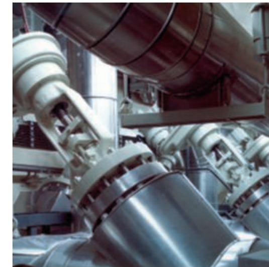
KSB-Schrägsitzventil mit Faltenbalg (Kernkraftwerk Stade)
