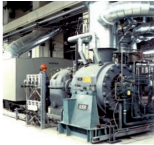
Pumpen der Baureihe RHD fördern Speisewasser in nuklearen Dampferzeugersystemen.
