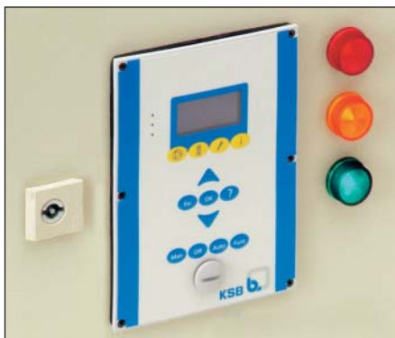
Fot. 3 Wersja CM – montaż w szafie sterowniczej
