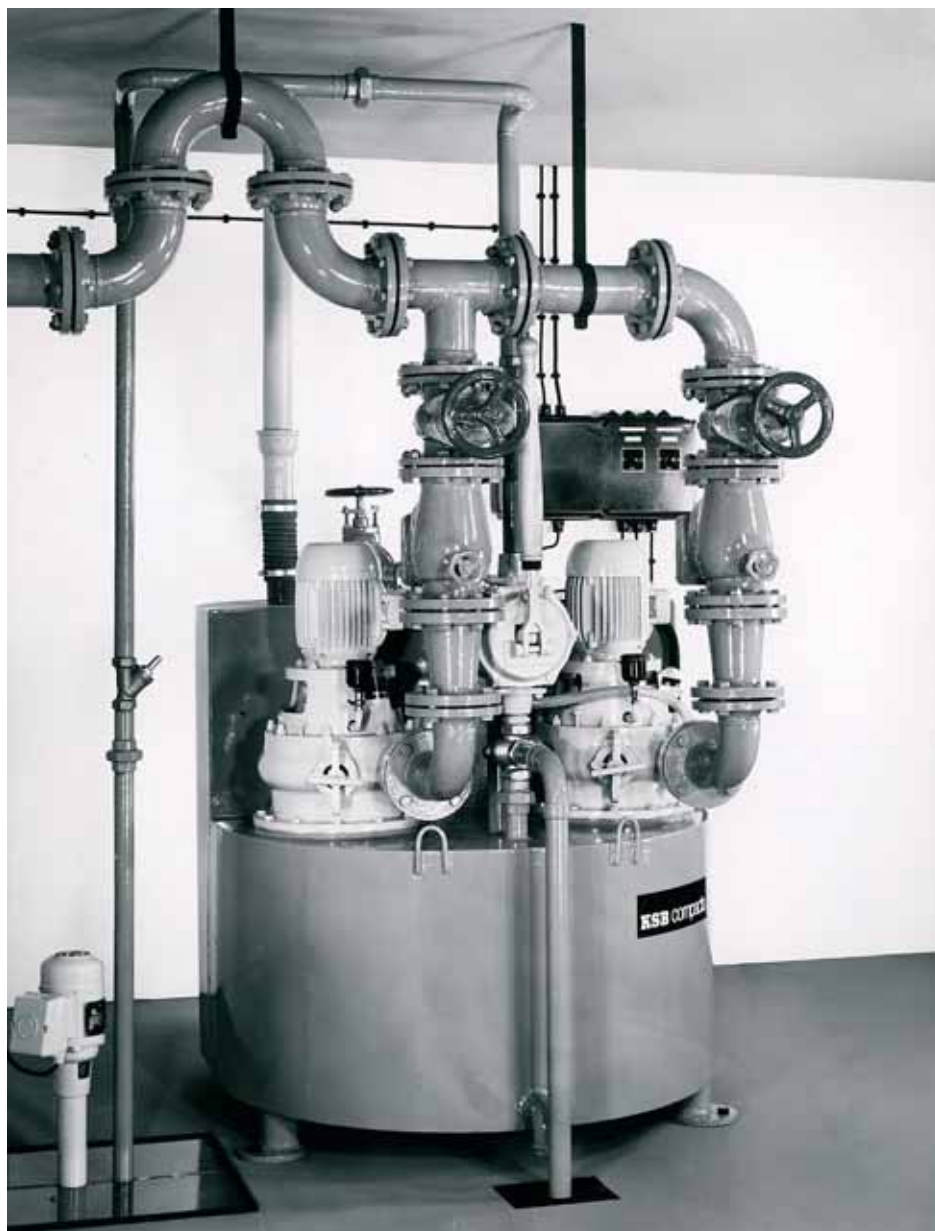
Rys. 3. Pierwsza kompaktowa przepompownia ze zbiornikiem gwarantującym pełną szczelność wprowadzona na rynek w 1966 roku przez koncern KSB
