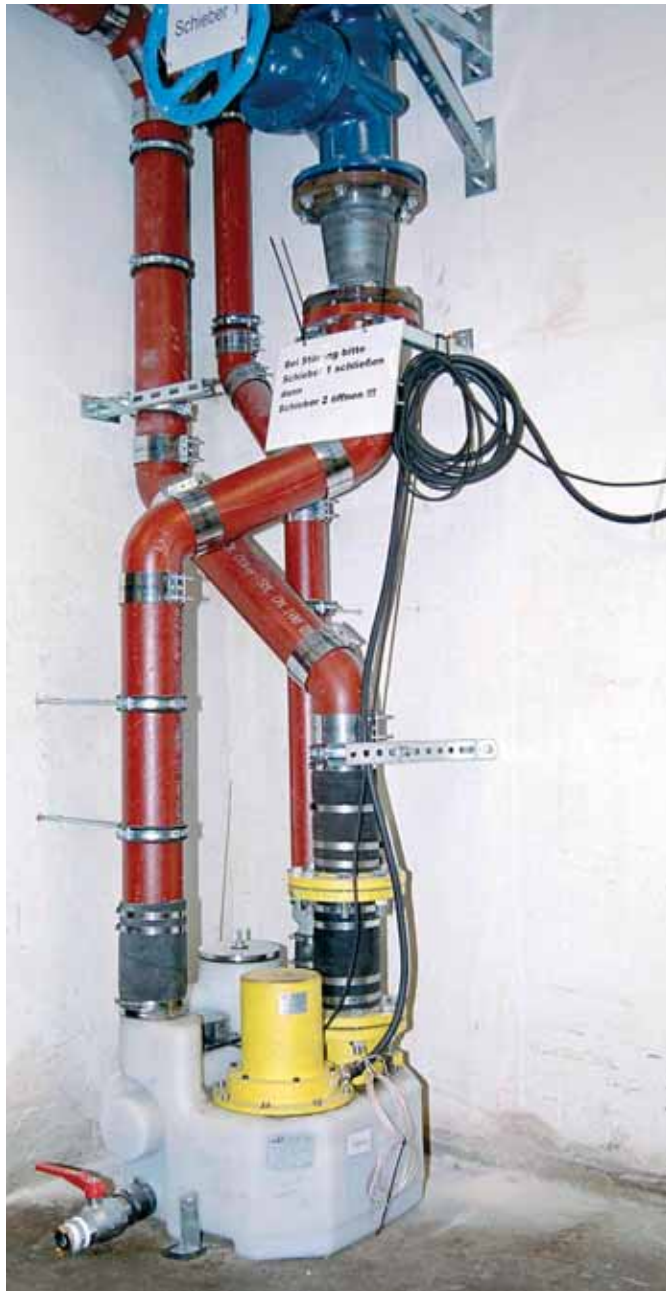
Rys. 4. Podstawowy zakres zastosowań zewnętrznych przepompowni ścieków to: usuwanie ścieków w trybie pracy ciągłej, usuwanie ścieków zagrożonych wybuchem, odprowadzenie wody opadowej z obszarów poniżej poziomu spiętrzenia.
