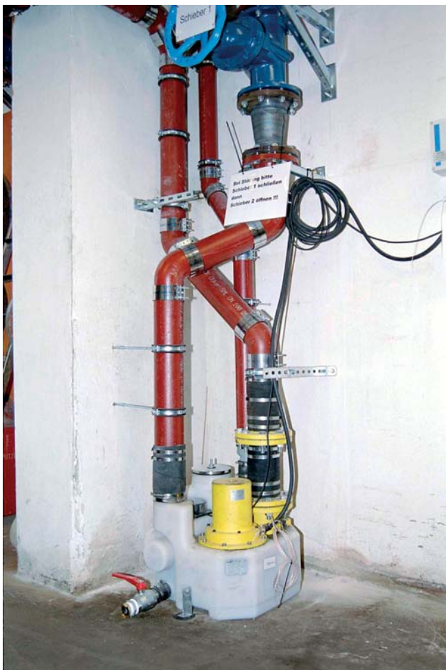
Rys. 2. Podstawowy zakres zastosowań zewnętrznych przepompowni ścieków to: usuwanie ścieków w trybie pracy ciągłej, usuwanie ścieków zagrożonych wybuchem, odprowadzenie wody opadowej z obszarów poniżej poziomu spiętrzenia. Firma KSB oferuje zewnętrzne pompownie ścieków o bardzo szerokim zakresie wydajności
