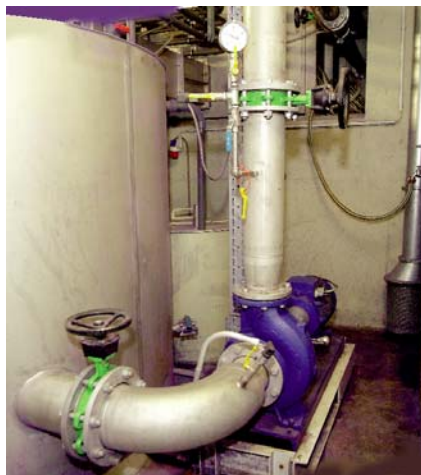
Poniżej kabiny lakierniczej znajduje się instalacja odbioru wilgoci z mgiełki lakierniczej. To zadanie wykonuje pompa własnej produkcji, sterowana systemem PumpExpert. Nieprawidłowości są dzięki temu szybko wykrywane, czasy przestoju w wyniku usterek – eliminowane, a żywotność urządzenia wzrasta.
