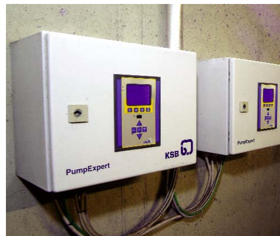
Poniżej kabiny lakierniczej znajduje się instalacja odbioru wilgoci z mgiełki lakierniczej. To zadanie wykonuje pompa własnej produkcji, sterowana systemem PumpExpert. Nieprawidłowości są dzięki temu szybko wykrywane, czasy przestoju w wyniku usterek – eliminowane, a żywotność urządzenia wzrasta.
