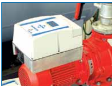
Varianta MM (motor-mounted), montáž přímo na motoru
