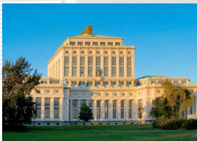
Vodárna v Praze-Podolí
